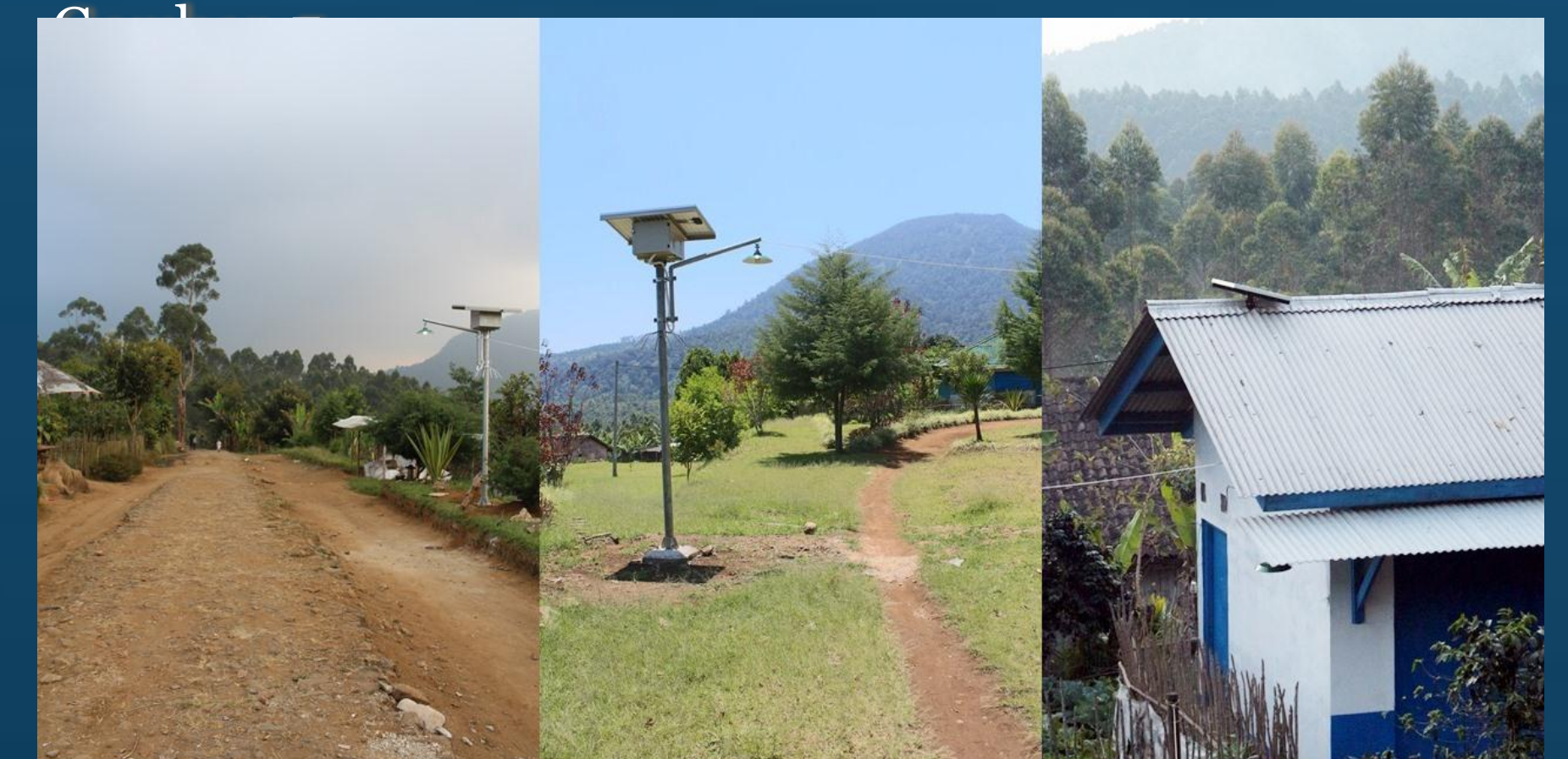
Gambar 7 Instalasi panel surya di Dusun Pangli
