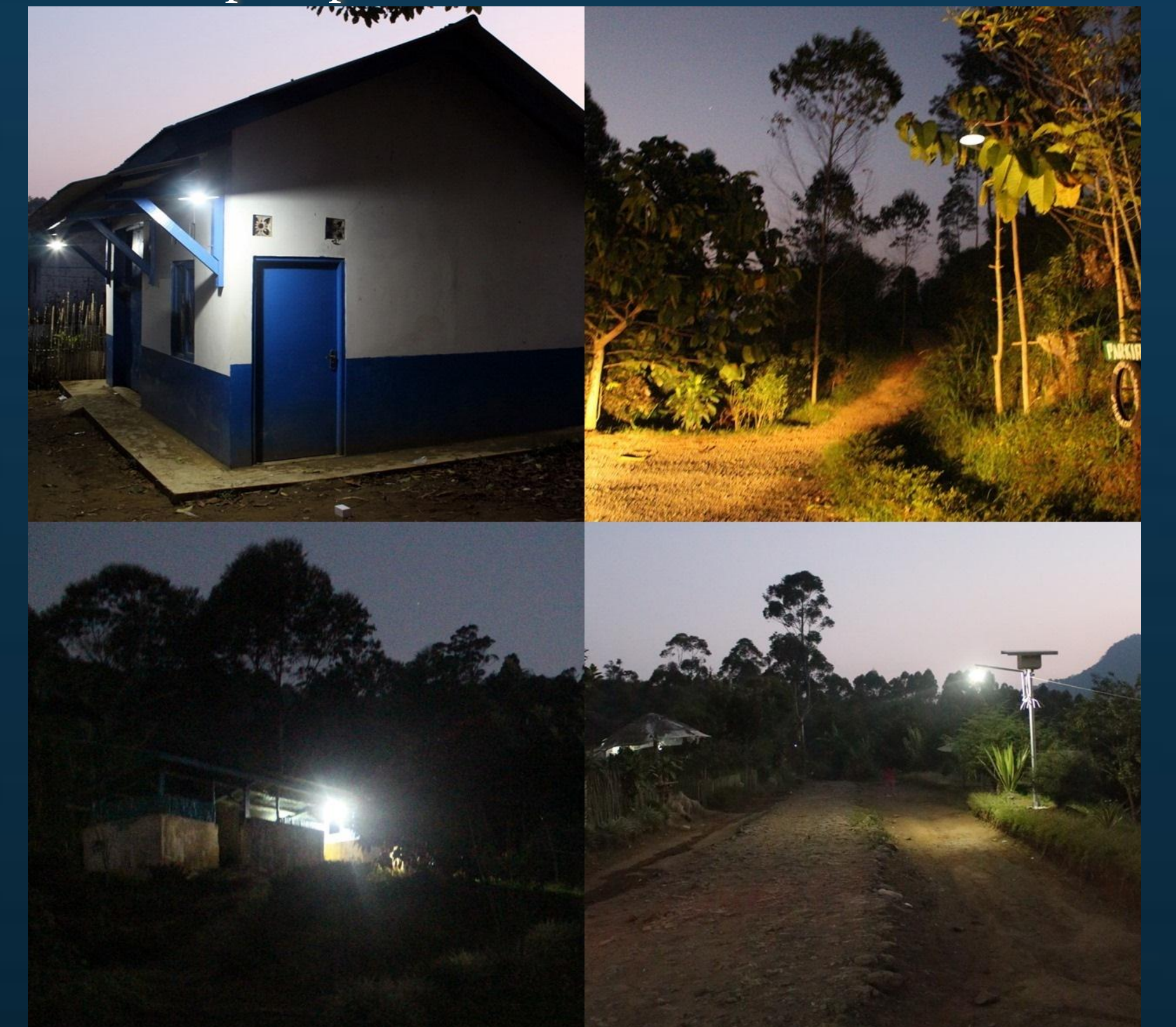
Gambar 8 Penerangan jalan, MCK umum, dan bangunan serba guna
